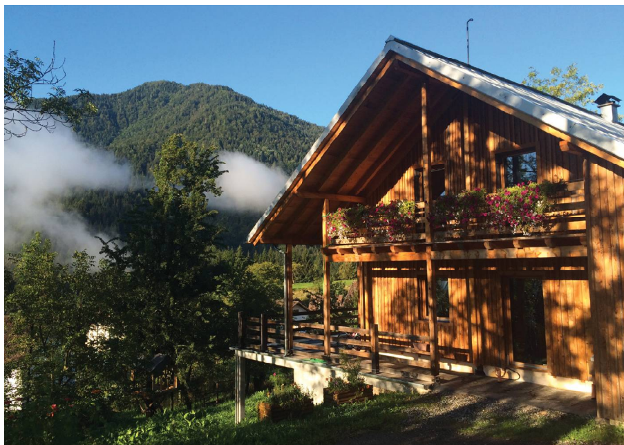
Fig. 1 > Casa di Legno Ecosostenibile - lato Est
